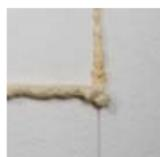
Mousse expansive manuelle ou pistolable destinée à combler les vides entre les plaques d'isolant.
