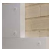
**Panneau Iso 15/38 BD** est une plaque d'isolant avec un  $\lambda$  de 0,038 W/m\*K et une masse volumique de 15 kg/m<sup>3</sup>. Les dimensions sont 500x1000 mm ou 600x1200 mm pour une épaisseur de 20 à 300 mm. Elle s'utilise dans le cadre des systèmes Revitherm/Revithermono collés et calés chevillés.
