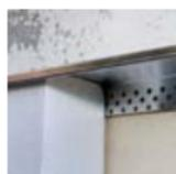
Il permet de protéger la partie supérieure des systèmes d'ITE, soit en arrêt haut, soit sous une maçonnerie existante insuffisamment débordante.
