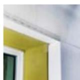
**Profilé goutte d'eau PVC + fibre Standard et Exclusif** sont des profilés en PVC et fibre de verre intégrée, de longueur 2,50 ml.
